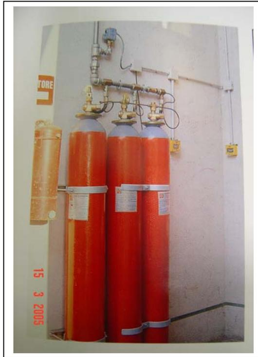
**Fig. 87 – Bateria de CO<sub>2</sub>**
